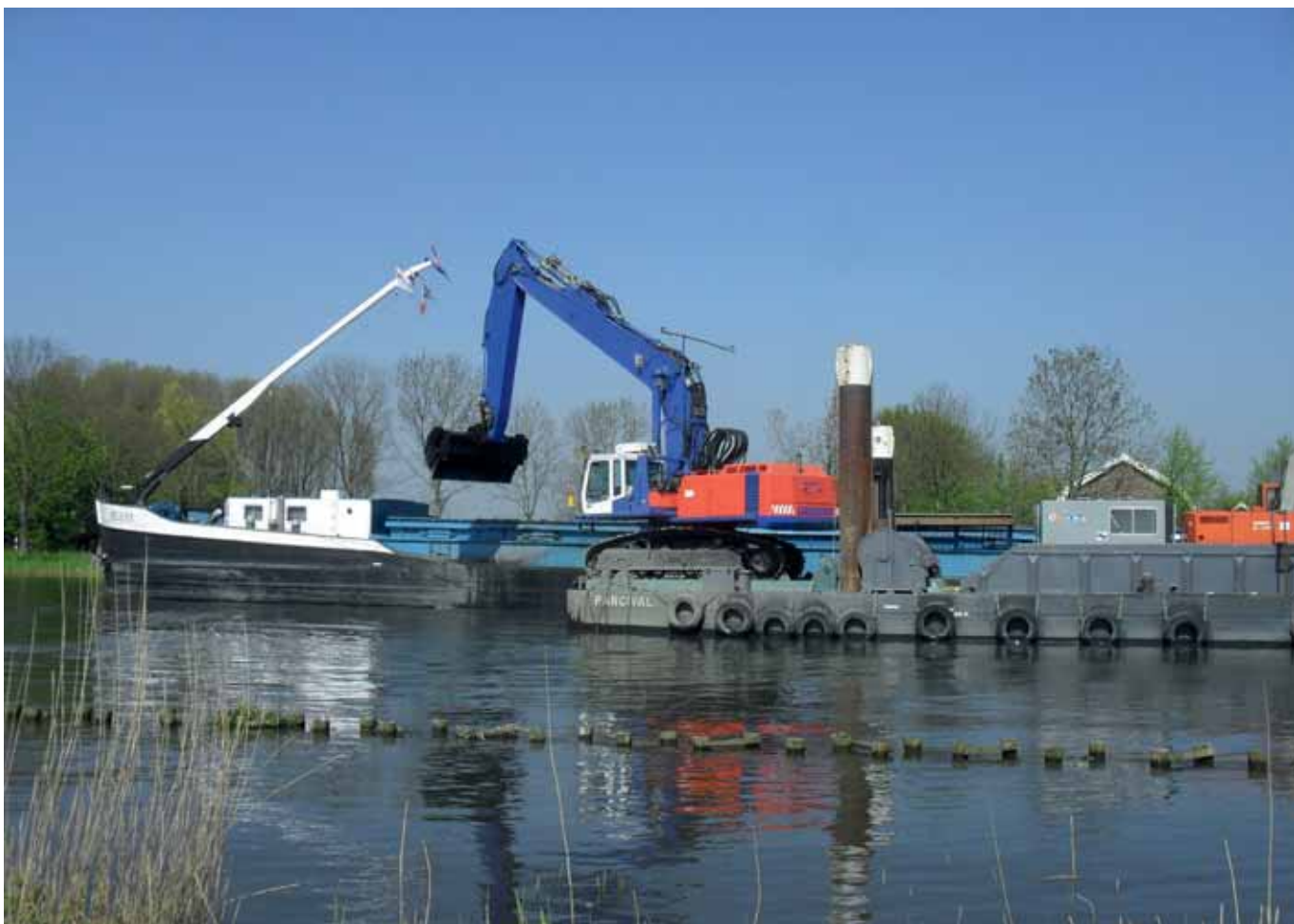
FIGUUR 3: HET UITEINDELIJK BAGGEREN VAN DE WATERBODEM.
